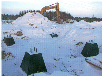
Рис. 5. Стержневые заделки и скальные фундаменты для решетчатых опор на ВЛ 330 кВ «ПС Лоухи – РП Путкинский – РП Ондский» (ЗАО «ЭФЭСк», Карелия, 2012): раскливающиеся анкера – анкерные болты, пазухи которых залиты мелкодисперсным цементным раствором; слева – арматурные, опалубочные и бетонные работы, справа – дизельный компрессор-электростанция на 9,6 кВт и на 4 комплекта пневмоинструмента; монолитные блоки скальных фундаментов в окончательном виде
