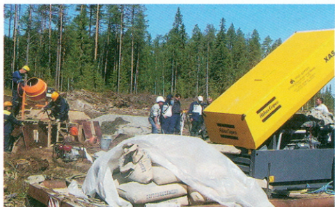
Рис. 5. Стержневые заделки и скальные фундаменты для решетчатых опор на ВЛ 330 кВ «ПС Лоухи – РП Путкинский – РП Ондский» (ЗАО «ЭФЭСк», Карелия, 2012): раскливающиеся анкера – анкерные болты, пазухи которых залиты мелкодисперсным цементным раствором; слева – арматурные, опалубочные и бетонные работы, справа – дизельный компрессор-электростанция на 9,6 кВт и на 4 комплекта пневмоинструмента; монолитные блоки скальных фундаментов в окончательном виде
