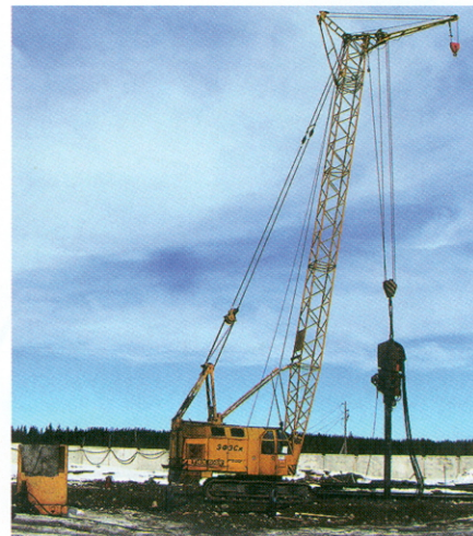
Рис. 6. Вибропогружение стальных свай (труба 325×14мм) длиной 12 м при помощи вибропогружателя MKT V-35 (вес 7 тн) с подвеской на гусеничном кране TAKRAF (ГДР) грузоподъемностью (г/п) 25 тс на площадке РП 330 кВ «Путкинский» («ЗАО «Энергострой», Карелия, 2012)
