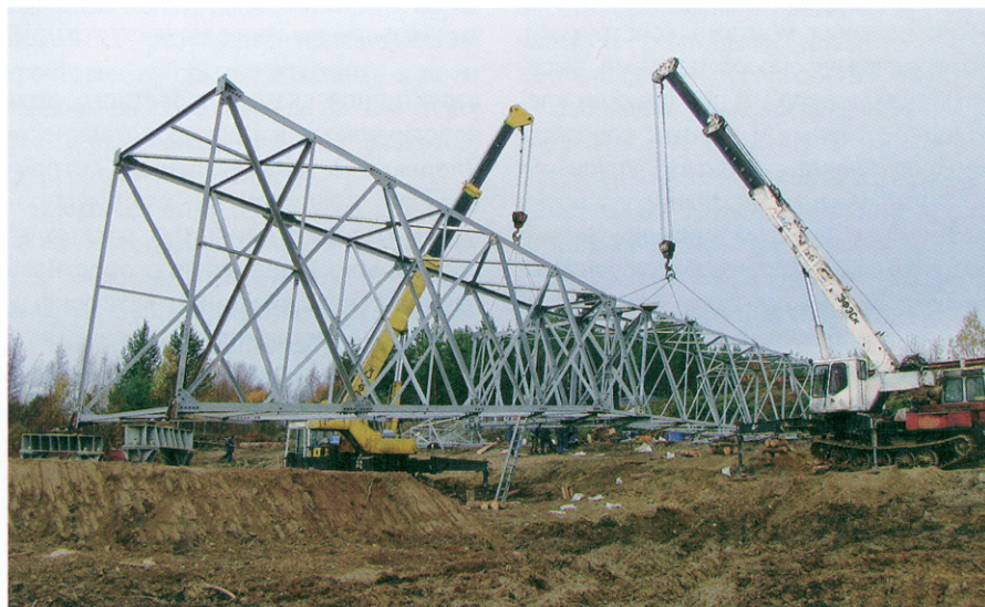
Рис. 8. Сборка и установка стальной решетчатой опоры У330-3+5,0 двумя кранами г/п 25 тс марки «Юрга» КС-5671 на гусеничном шасси ТТ-4М способом поворота относительно горизонтальной оси на ВЛ 330 кВ (Карелия, 2012)
