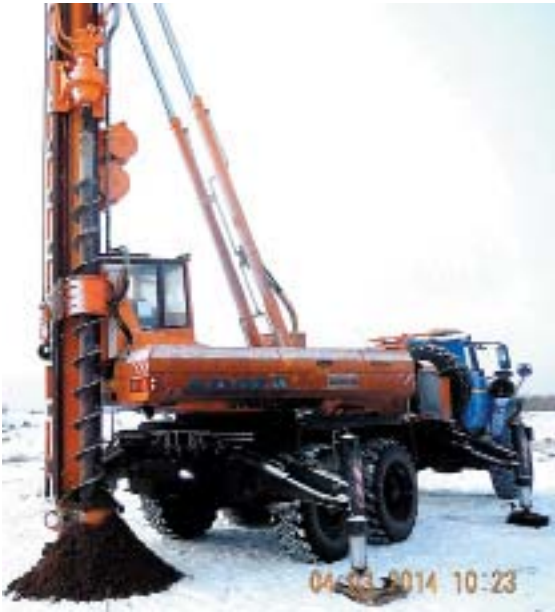
Рис. 7. Бурильно-сваебойная машина БМ-811М: эффективное бурение лидерных скважин на глубину 15м перед завинчиванием винтовых свай (переход ВЛ 220 кВ через р. Печора в Республике Коми; фото: 03.2014)
