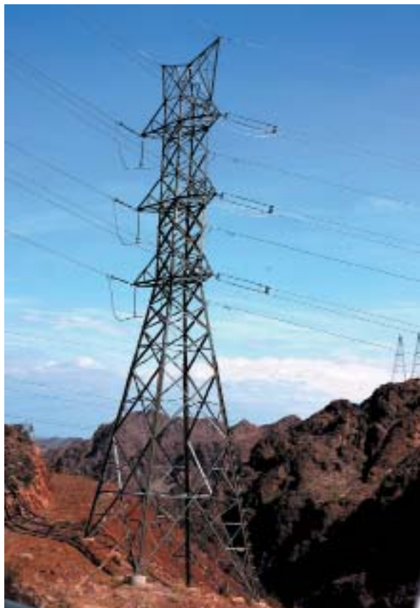
Рис. 5. Стальная косогорная анкерно-угловая опора на буронабивных сваях, возведенная в сложных горных условиях, на отходящих ВЛ 345 (230) кВ от подстанций ГЭС им. Г.Гувера (строительство: 1931-35 годы, Невада; фото автора, июль 2013)
