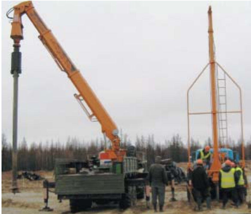
Рис. 10. Универсальная бурильная машина УБМ-85 и бурильно-крановая машина БКМ-515 на свайных работах в Новом Уренгое по устройству фундаментов из стальных винтовых свай в ММГ (06.2007)
