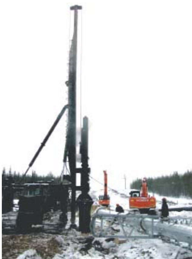
Рис. 6. Отечественный сваебойный агрегат СП-49А с дизель-молотом типа СП-76 для вертикальных и наклонных свай, ударно погружающий стальную сваю-оболочку диаметром 0,8 м на глубину 7,0 м через «подбабок» на строящейся ВЛ 220 кВ «Печорская ГРЭС — Ухта» (2013); до забивки свая устанавливается в начальную скважину диаметром 0,9 м на глубину до 1,5–2,0 м, выполняемую буро-крановой машиной SF-6 (Италия)
